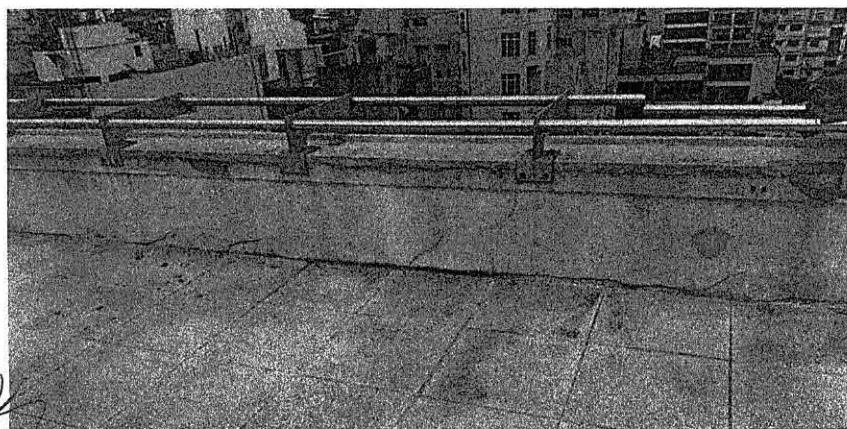
Imagen 5 (limpieza y relleno de fisuras en muros perimetrales)
